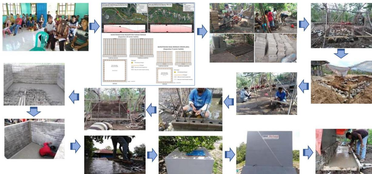
**Gambar 5.** Proses PRA pada pembangunan bak distribusi air bersih di Desa Tanah Merah, Kab. Ende, Flores-NTT
